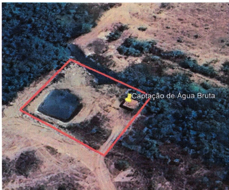
Imagem 01: Localização da captação superficial.
