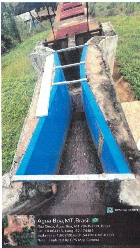
Vista da Calha da ETE
