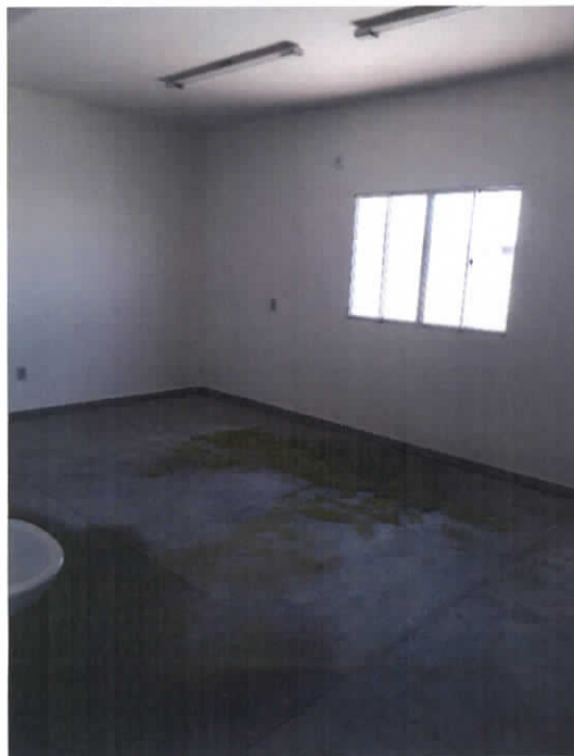
Foto 13 – Sala Observação Pediátrica Data: 24 de janeiro 2017
