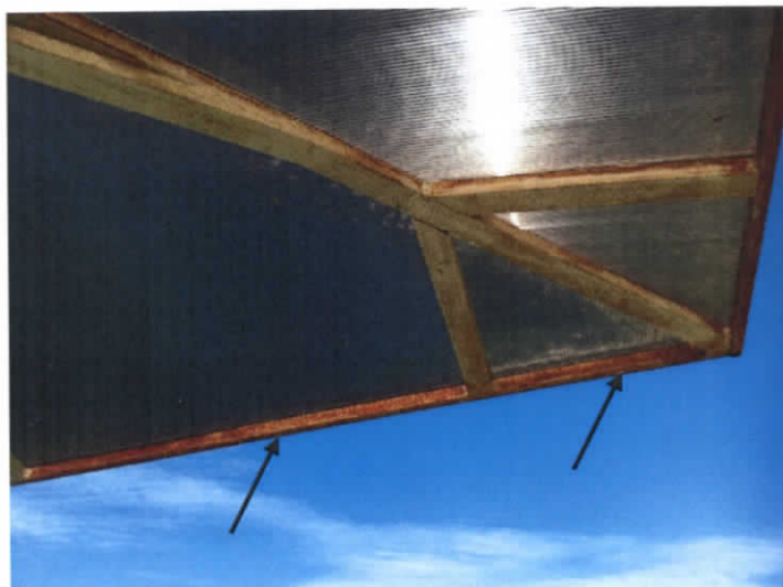
Foto 04 – Cobertura Varanda Sala de Espera Data: 24 de janeiro 2017
