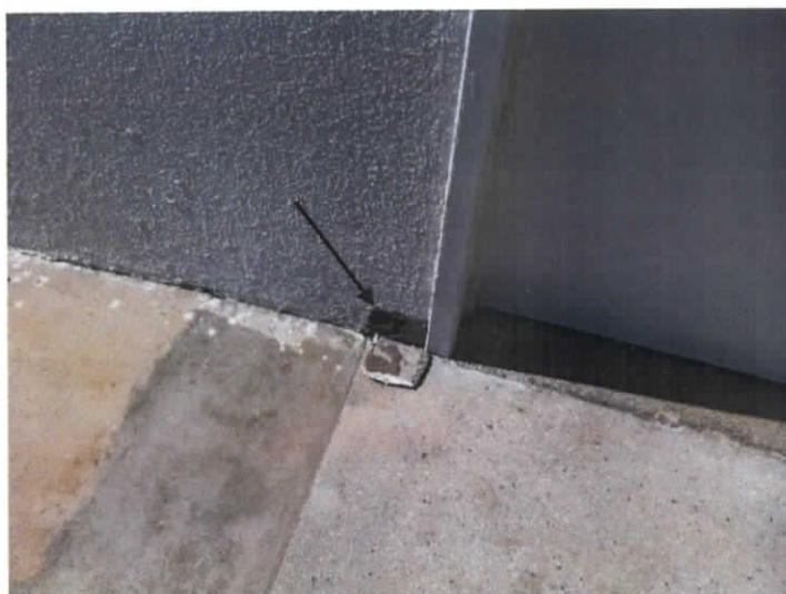
Foto 02 – Cobertura do Abrigo Ambulância Data: 24 de janeiro 2017
