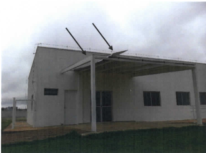
Foto 01 – Cobertura do Abrigo Ambulância Data: 24 de janeiro 2017
