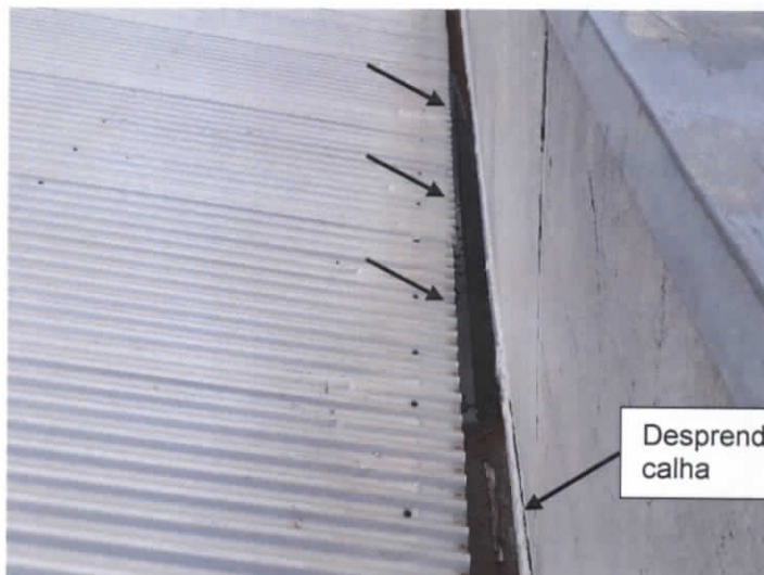
Foto 35 – Acumulo de água da chuva na calha Data: 24 de janeiro de 2017
