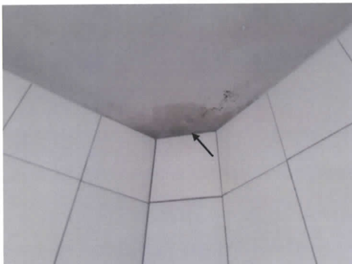
Foto 18 – Laje de cobertura do abrigo de resíduos Data: 24 de janeiro de 2017
