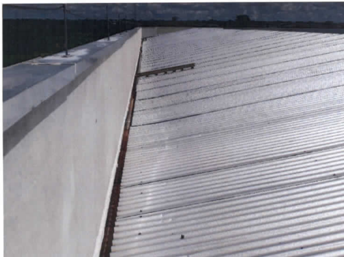
Foto 26 – Vista da cobertura, detalhe calha Data: 24 de janeiro de 2017
